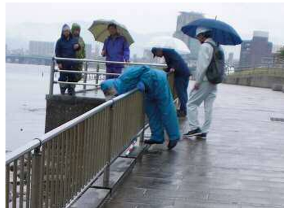
河川協力団体との点検実施状況
